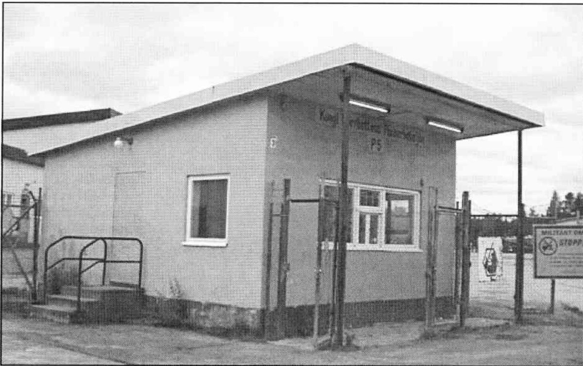
Den gamla kasernvakten som troligen är från slutet av 1950-talet har nu fått ge vika för grävskoporna. De senaste åren har lokalen fått fungera som plutonsförråd.
